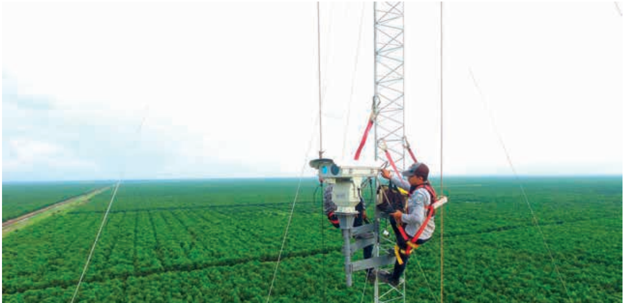
► Menara Thermal / Caption (Menara Thermal untuk Memantau Titik Panas sebagai upaya pencegahan Karhutla. Thermal Monitoring for Hot Spot Monitoring as Forest Fire Fire Prevention.
