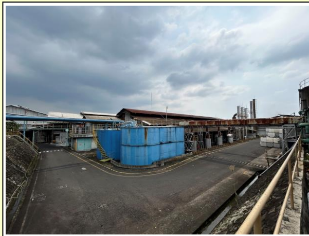
Bangunan Diesel Engine dan Aux Boiler
